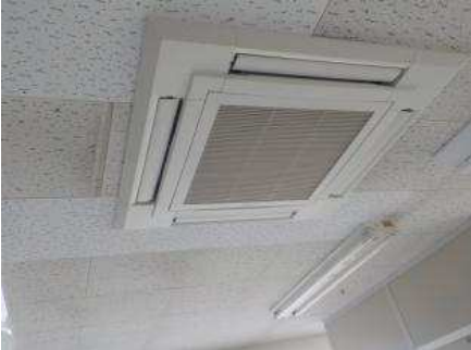
①R22冷媒使用の空調交換 食堂の空調の交換を実施
